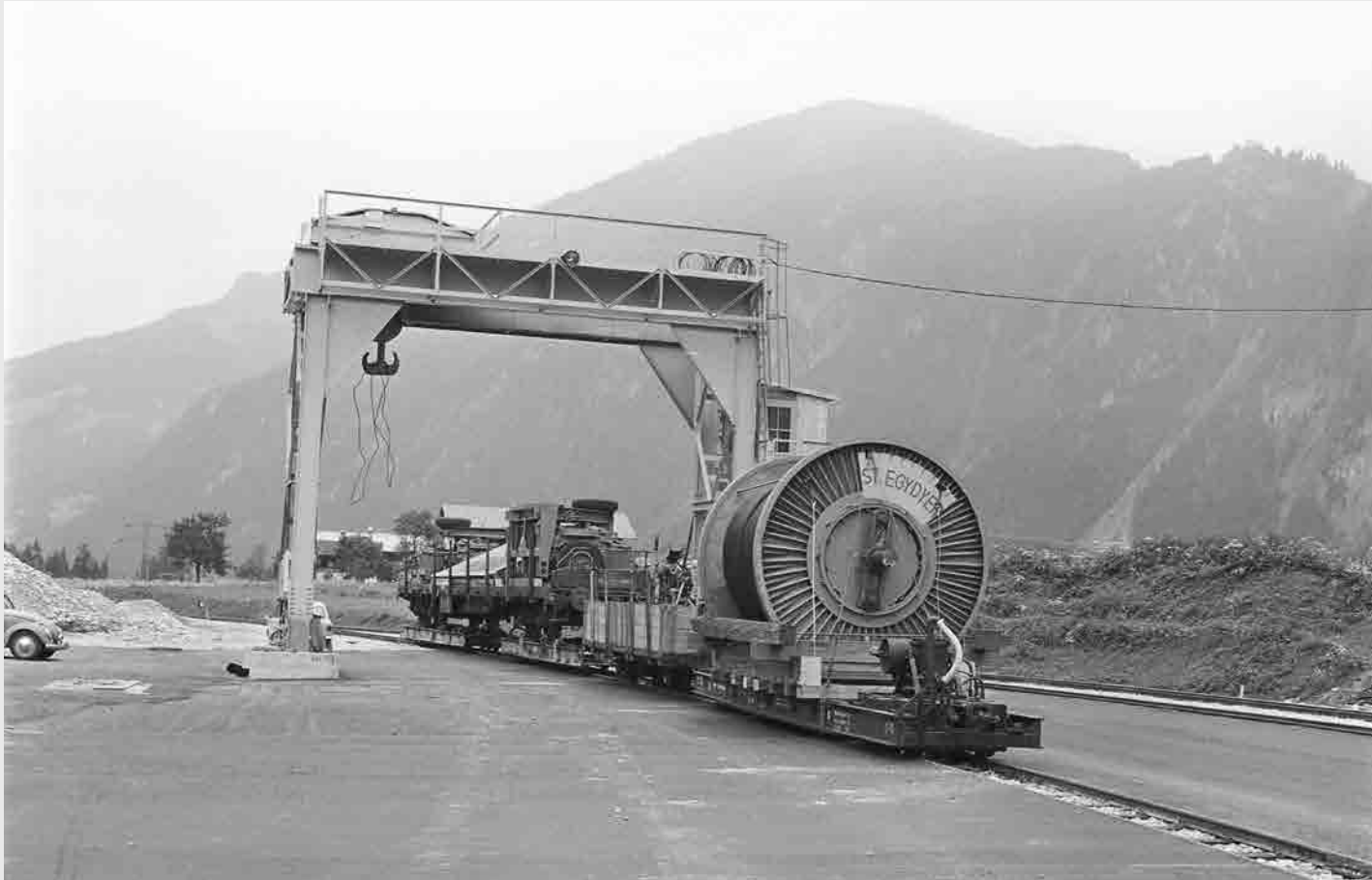
Am 8. Juli 1967 warten diverse angekommene Güterwagen beim Portalkran des Kraftwerks-„Bahnhofs“ bei Mayrhofen auf die Entladung. Foto: Gerhard Luft
