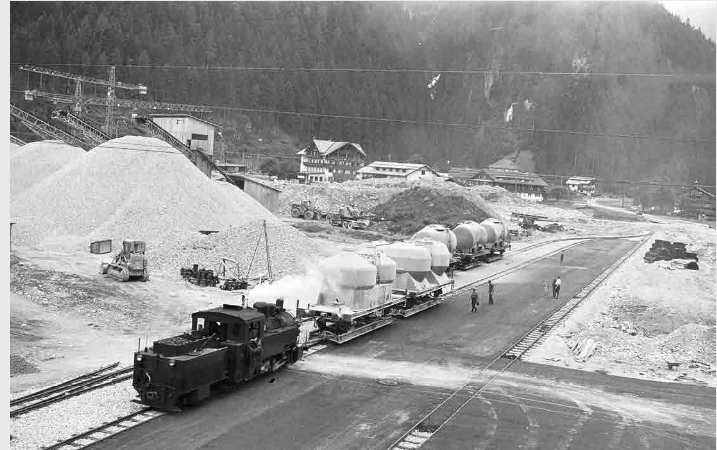
Dieses Bild beschert uns einen Überblick über die Kraftwerksbaustelle am 8. Juli 1967. Vor den Bergen an Baumaterial hat Lok 4 leere Zementwagen übernommen und verlässt den Baustellen-„Bahnhof“. Foto: Gerhard Luft
