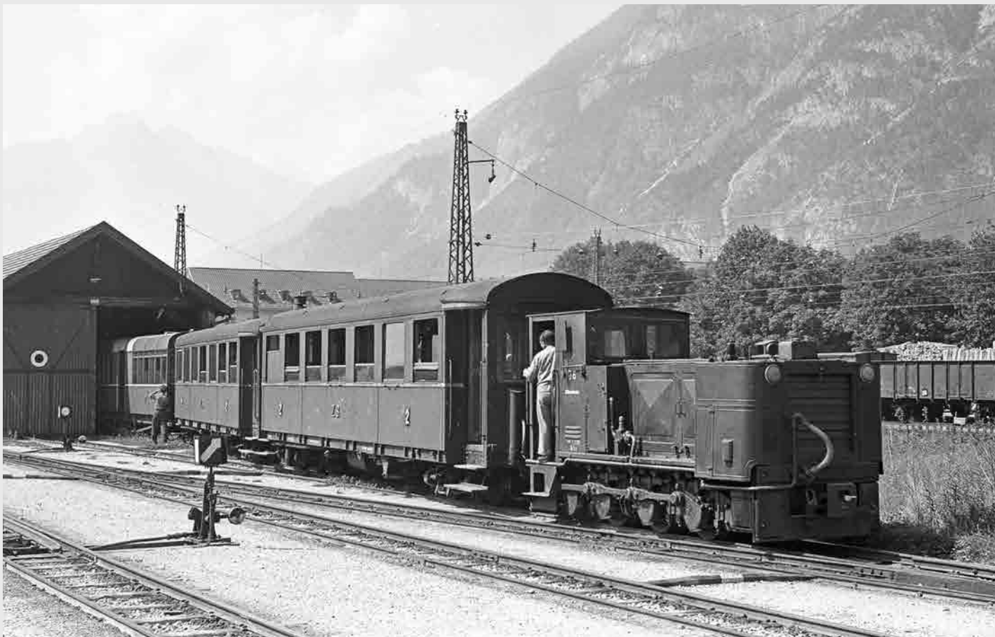
Die Vershublokomotive D 6 vor der Wagenhalle am 1. September 1958. Als dritter Waggon ein Aussichtswagen für die Reisenden. Im Hintergrund befindet sich der Bahnhof Jenbach der ÖBB und hinter diesem Bahnhof die Achenseebahn. Foto: Alfred Luft
