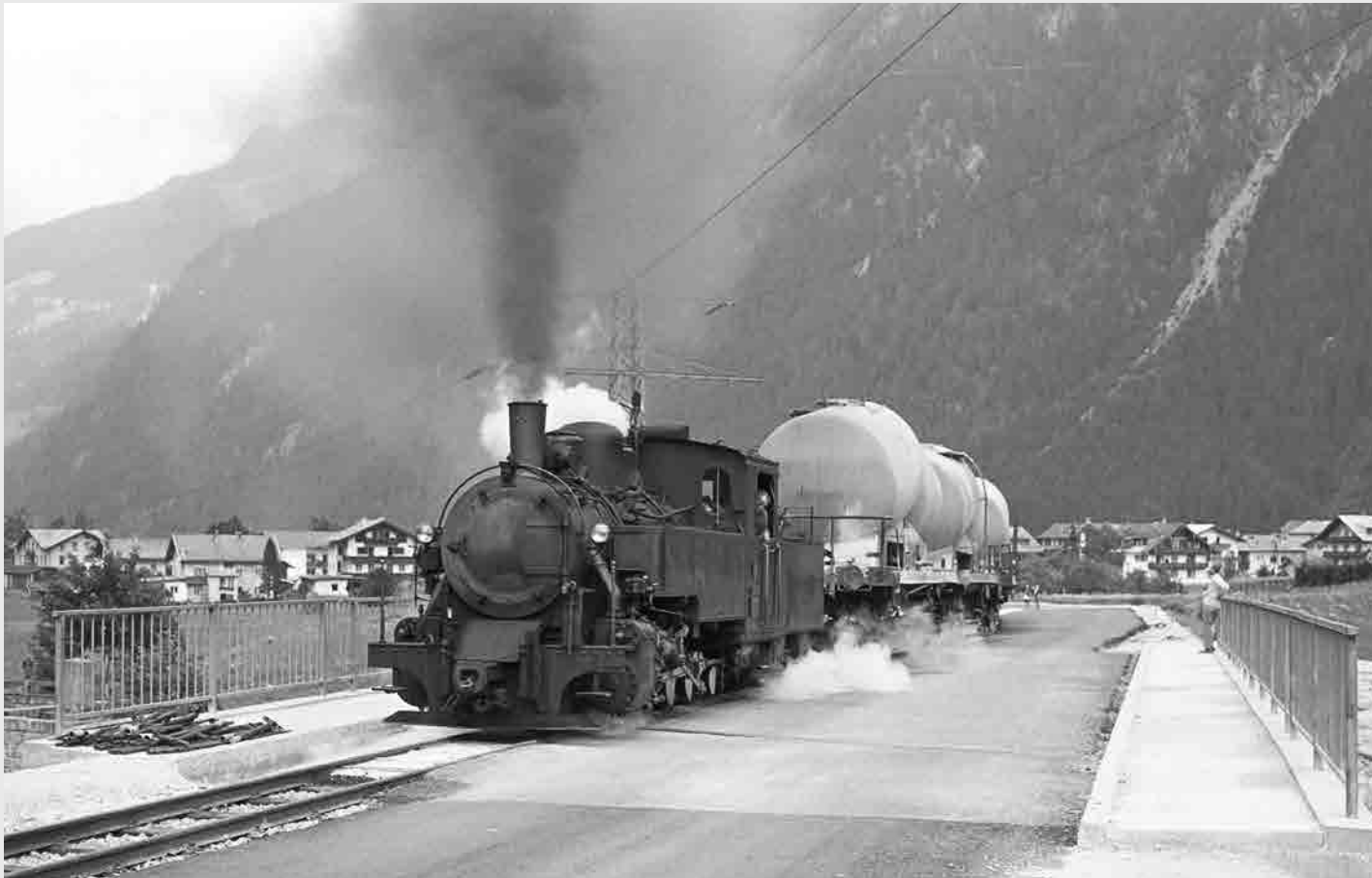
Am 8. Juli 1967 befährt Lok 4 mit einigen Zementwagen die eigens für Bahn und Straße errichtete Brücke zur Kraftwerksbaustelle. Foto: Gerhard Luft
