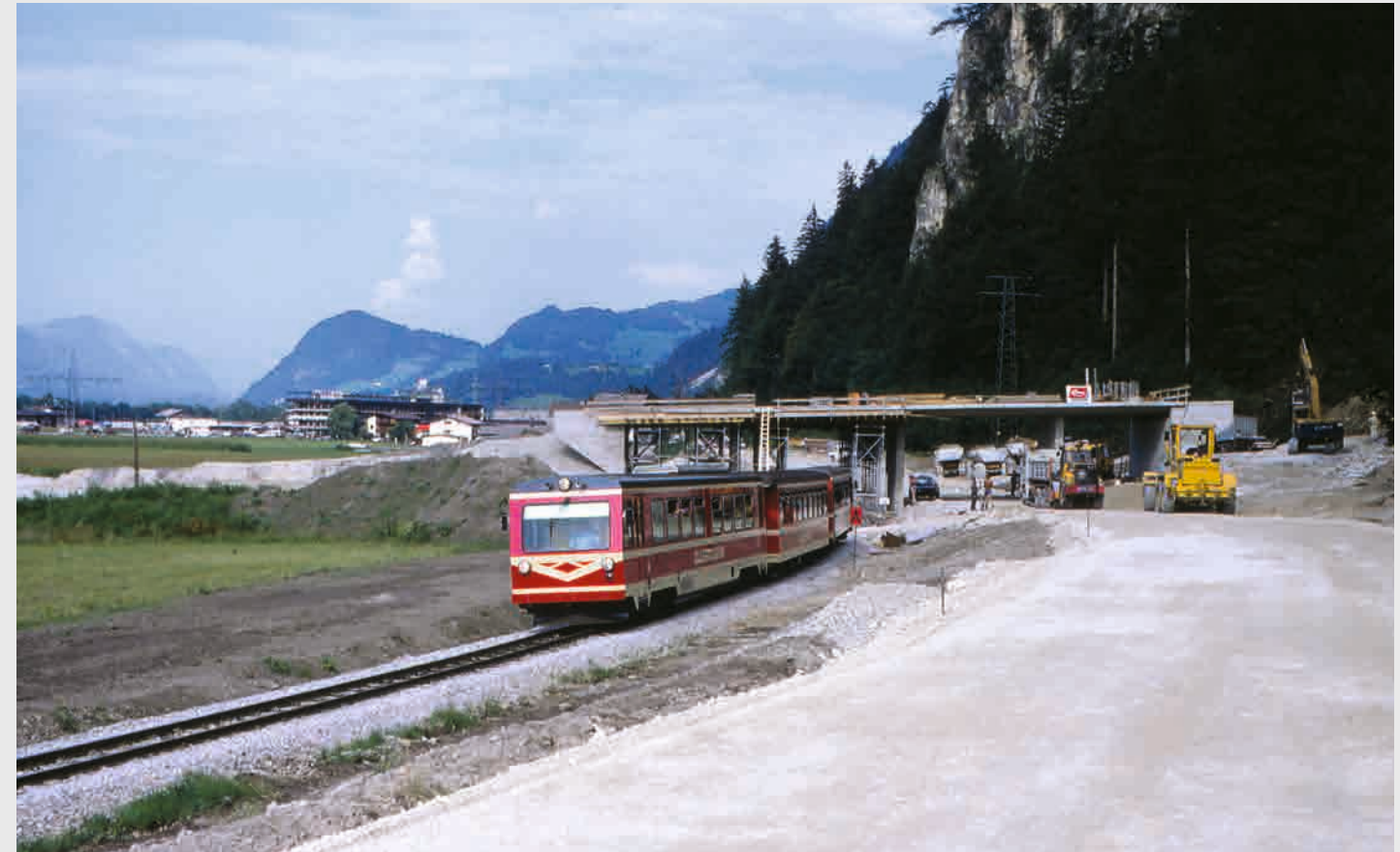
Der zunehmende Straßenverkehr in das Zillertal machte es nötig, das Nadelöhr in Strass zu umfahren. So wurde 1993 der Brettfall-Tunnel errichtet und direkt zur Inntal-Autobahn angebunden. Der VT 6 hat die im Bau befindliche neue Tunnelzufahrt unterfahren und setzt seine Reise auf der korrigierten Trasse Richtung Rotholz und Jenbach am 4. August 1993 neben der ebenfalls verlegten Landesstraße von Strass nach Rotholz fort. Foto: Albert Ditterich
