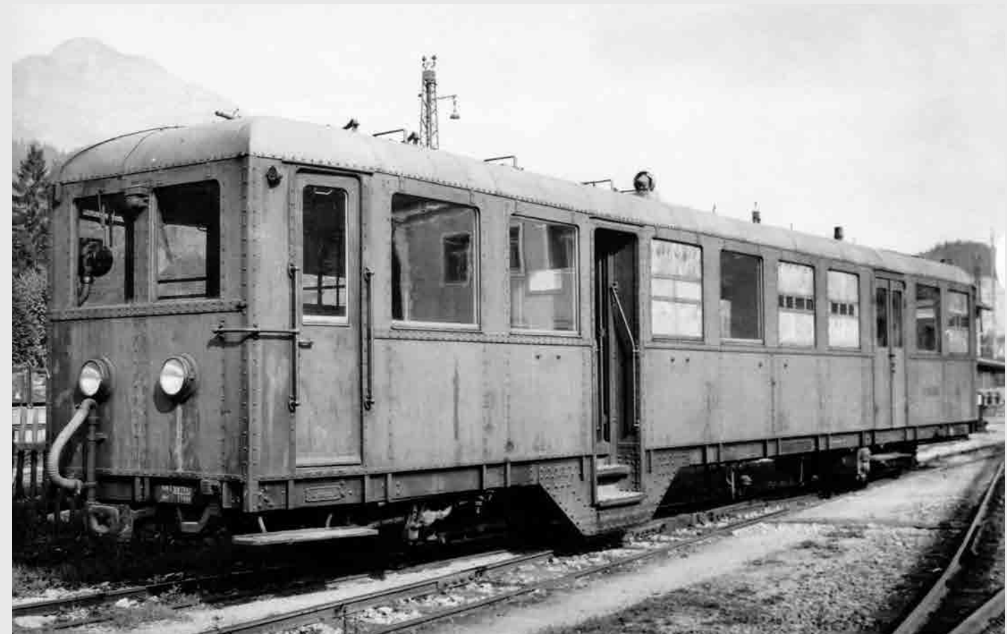
Otto Zell hielt in den Jahren 1942/43 den ehemaligen benzinelektrischen Triebwagen BET 101 im Bahnhof Jenbach fest, der zum Aufnahmezeitpunkt als Beiwagen Ca 101 diente und ab 1953 als dieselhydraulischer VT 3 eingesetzt wurde. Foto: Otto Zell/Archiv Griebel
