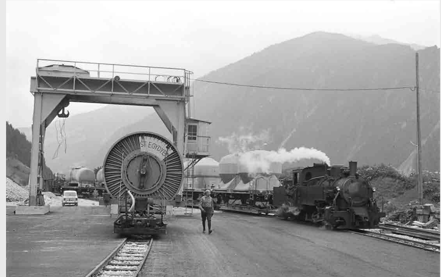
Im Bild der Portalkran für die Entladung der Lieferungen für die Baustelle. Rechts die Lok 4 mit Zementwaggons und in der Mitte ein Rollwagen mit einer Kabelrolle der Firma St. Egydyer, die am 8. Juli 1967 angekommen sind. Foto: Gerhard Luft
