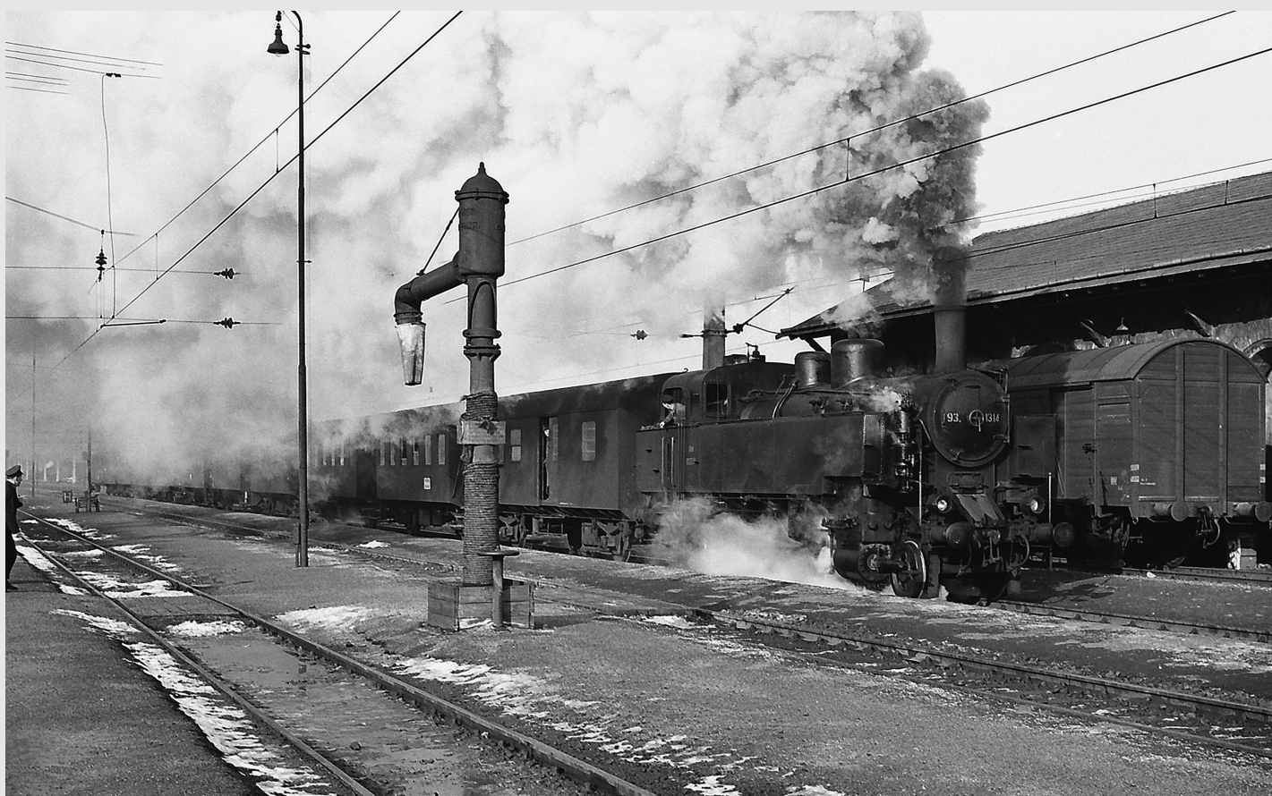
Der im vorhergehenden Bild im Hintergrund wartende P5415 wurde nach dem Wasserauffüllen von der 93.1314 übernommen. Der Dienstwagen pendelte zwischen Puchberg und Leobersdorf. Der Lokführer hat den Regler kräftig geöffnet. KW
