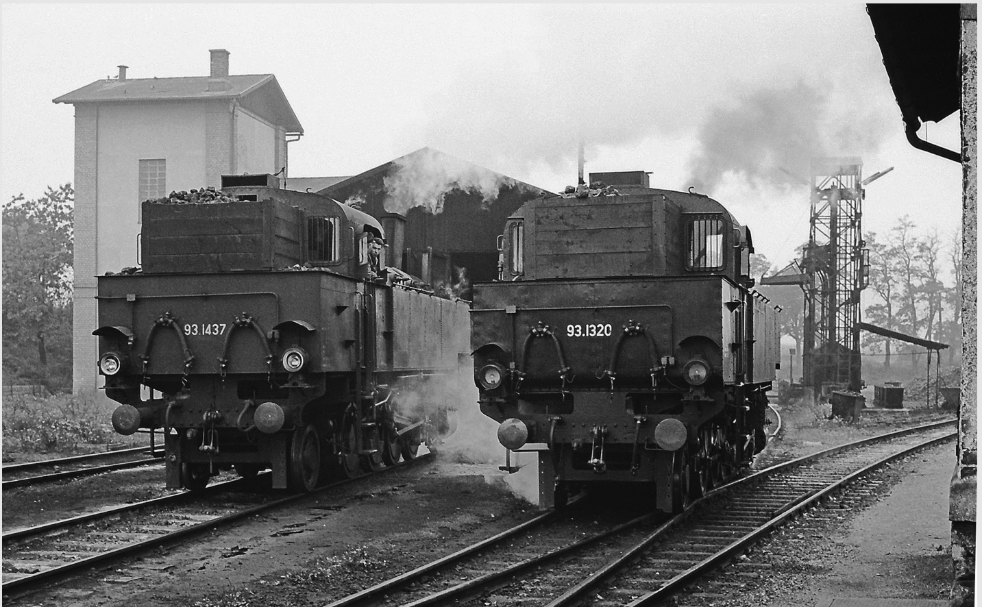
In Wittmannsdorf gab es ein Heizhaus mit Wasserkran, Bekohlungsturm und Drehscheibe, das bei Bedarf von den Dampflok frequentiert wurde. 93.1320 und 1437 warten am Samstag, dem 28.9.1968, auf ihren nächsten Einsatz als Doppeltraktion nach Puchberg. KW
