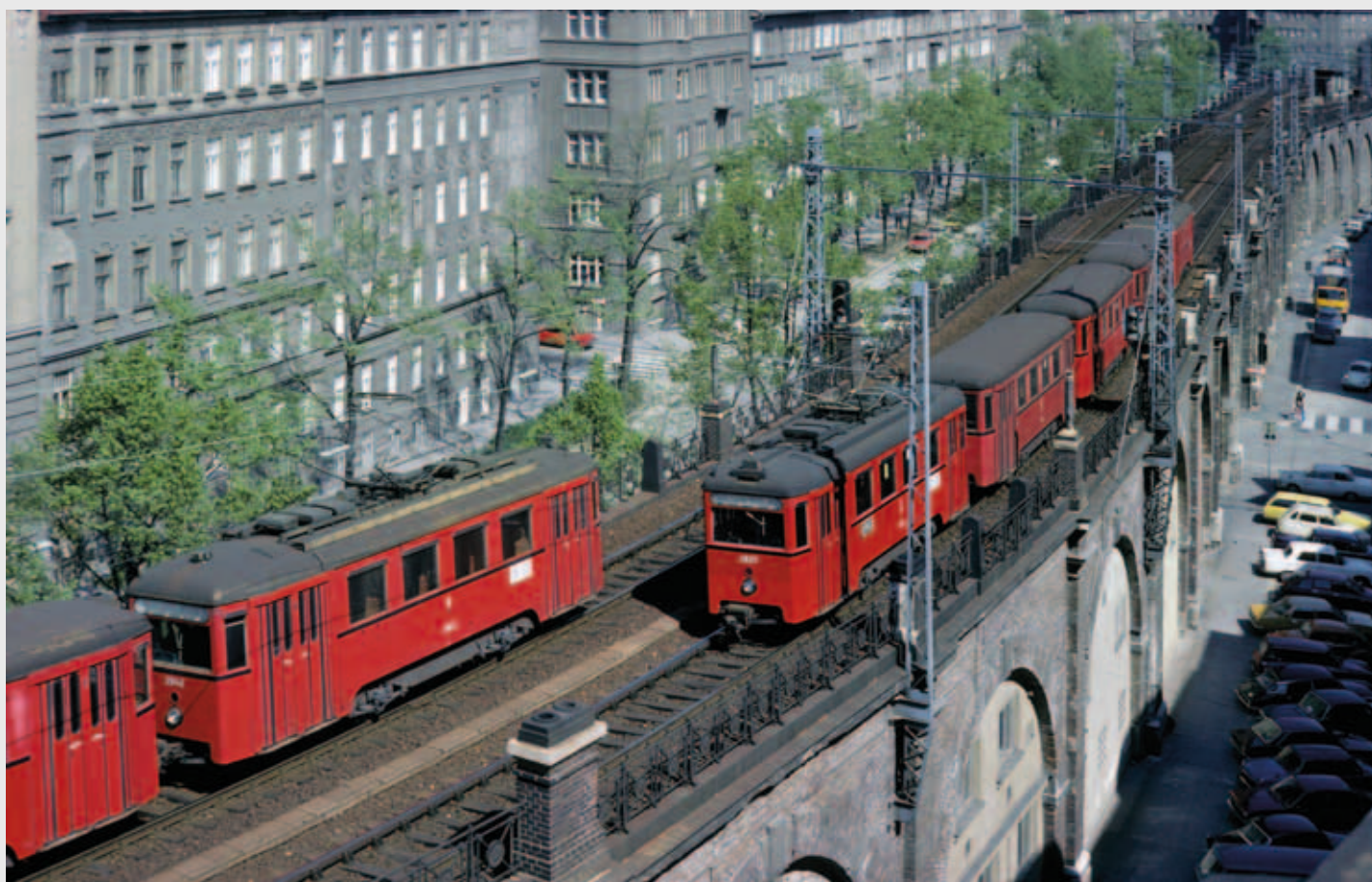
Diese Begegnung zweier Züge mit den Triebwagen N 1 2925 und 2942 wurde am 17. April 1977 vom Hochhaus aus dokumentiert. In den Bögen der Stadtbahn befinden sich heute Geschäftslokale und diverse Gastronomiebetriebe. Foto: Alfred Luft.
