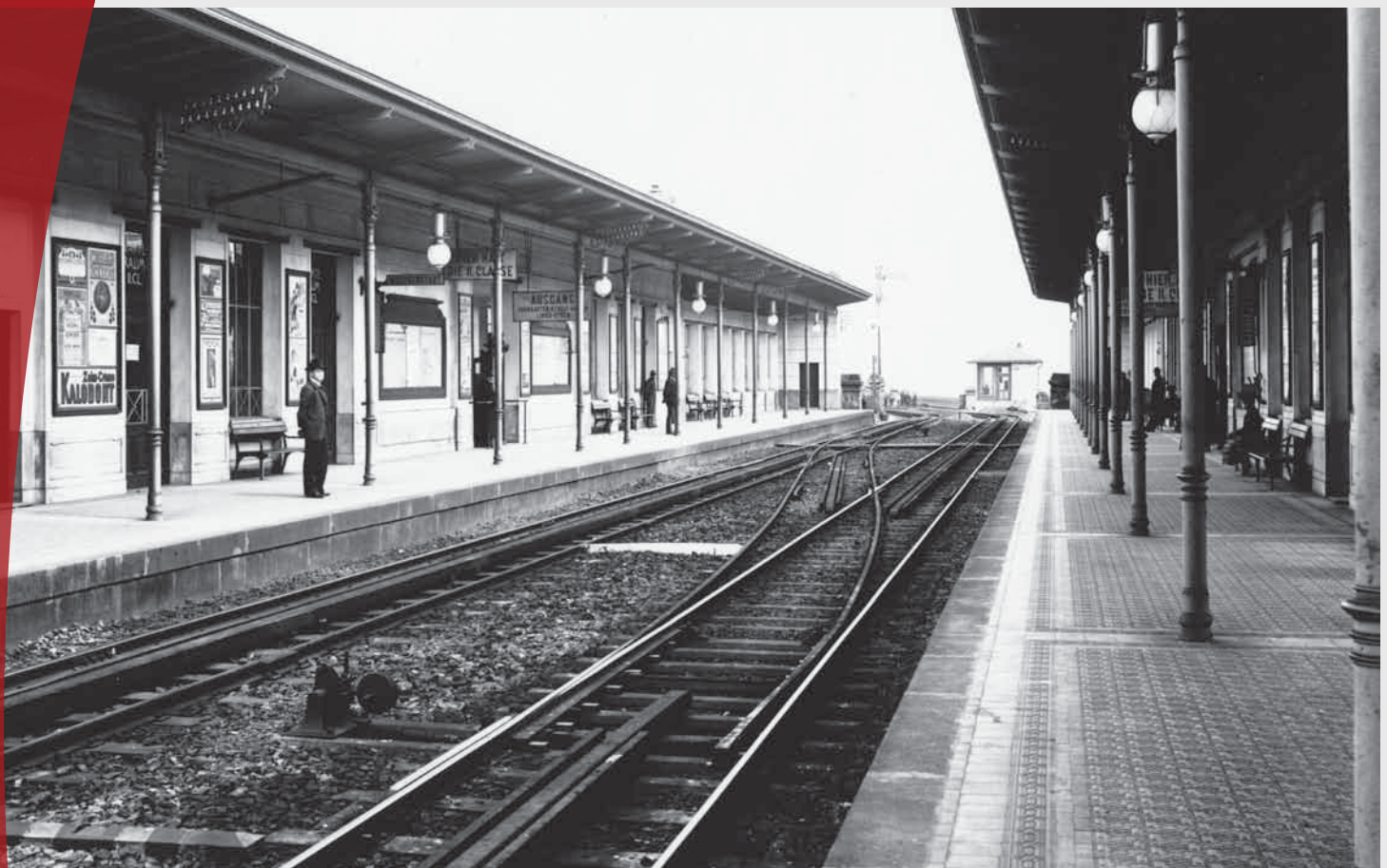
In der Haltestelle Nußdorfer Straße ist die Stromschieneanlage für den elektrischen Probetrieb bereits fertiggestellt. Man erkennt, dass die Stromschiene im Bereich der Weiche unterbrochen war, wobei die Verbindung beider Hälften mit unterirdisch verlegter Kabel erfolgte. Foto: Sammlung Josef Hlavač.
