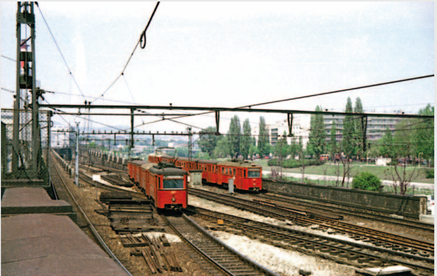
Am 7. Mai 1976 hat Josef Hlavač diese Szene festgehalten – eine Begegnung nach der Station Friedensbrücke. Links die Linie WD in Fahrtrichtung Heiligenstadt und von der Rampe kommt eine Garnitur der Linie GD in Richtung Hietzing. Diese Gleisanlage wurde im Zuge des U-Bahn-Baus umgebaut.
