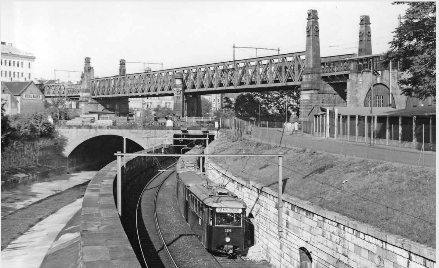
Ein Fünf-Wagen-Zug der Linie GD mit dem Triebwagen 2898. Im Hintergrund erkennt man die Wientalbrücke der Gürtellinie, deren Rampe im Zuge des Baus der U6 komplett neu errichtet wurde. Ebenso wurde auch die U4 in diesen Abschnitt neu trassiert. Dies war Voraussetzung für ein neues Verkehrsbauwerk, die heutige Umsteigestation Längengasse. Foto: Josef Hlavač.
