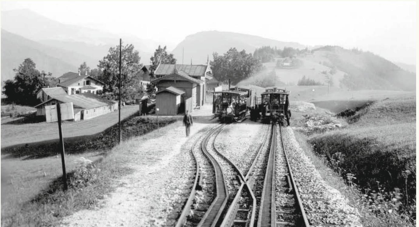
*Zugkreuzung in der Station auf der Zistelalm. Soeben ist auf dem in Blickrichtung rechten Gleis der talwärts fahrende Zug eingefahren. Am linken Gleis der bergwärts fahrende Zug. Der Stationsbeamte hat sich gerade auf den Weg zum Umlegen der Weiche 2 gemacht, um den Fahrweg für den Zug zu stellen. Links von der Station die Gebäude der Zistelalm um 1910.*
