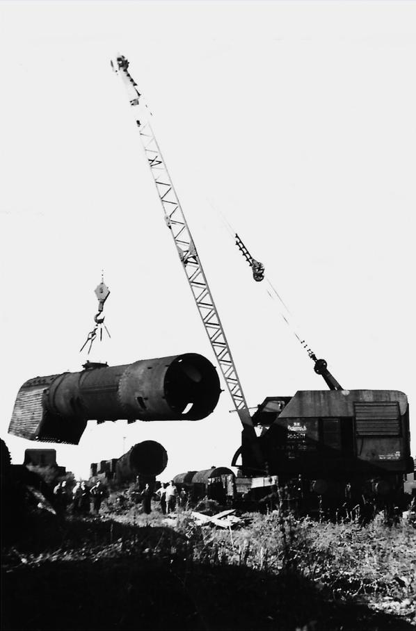
Belastungsprobe des mit Benzin angetriebenen 20 t-Schiendrehkrans 966.201, Bauart „American“, mit einem Kessel der Lokreihe 52. Gewicht 19 t, Auslegerlänge 15 m. Interessant ist die Anschrift „US-Zone Österreich“. Leider ist kein Aufnahme-datum verzeichnet.
