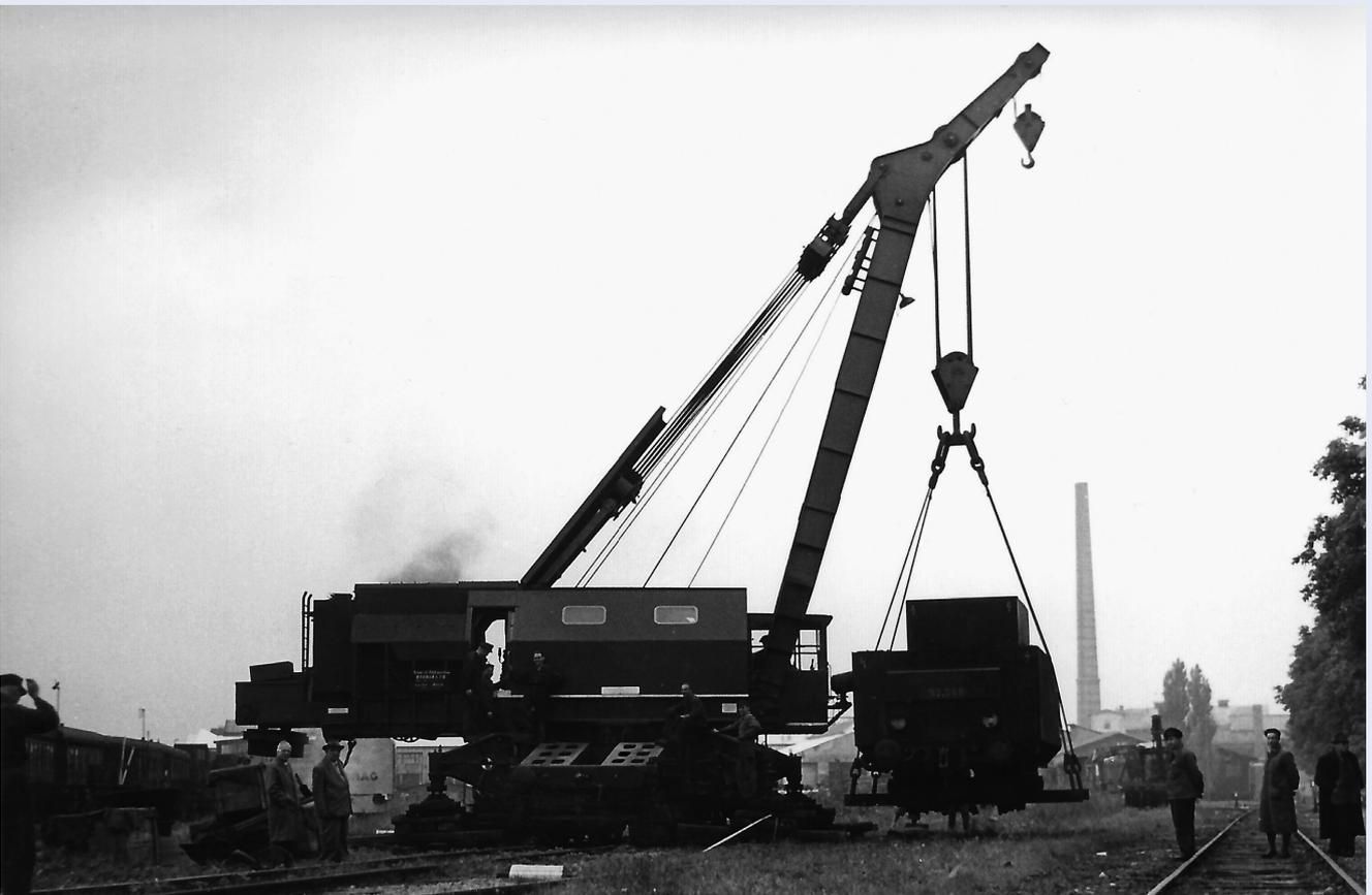
Belastungsprobe des Dampfkran 966.402 mit einem Steifrahmentender. Der Kran hatte eine Tragfähigkeit von 45 t bei 6 Metern Ausladung. Die Kranbelastung fand anlässlich der Abnahme von der Lieferfirma am 16. Oktober 1958 statt.
