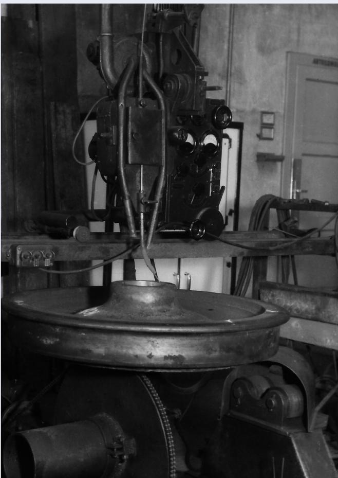
Nabenaufschweißen, hier noch mit blanken Elektroden. Interessant ist die Eigenkonstruktion zum langsamen Drehen des Radkörpers. Durch den Verschleiß, der beim Auf- und Abpressen des Radkörpers (Felge) von der Radsatzwelle entstand, musste der Nabensitz aufgeschweißt und dann auf das neue Pressmaß ausgedreht werden. (15. September 1954)
