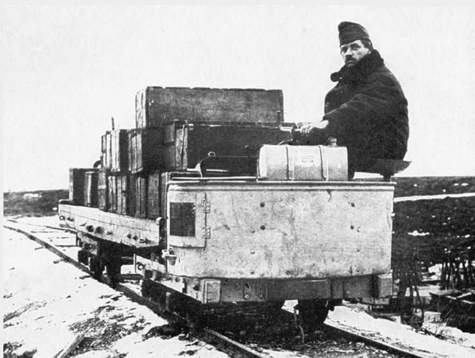
*Austro Daimler Motorfeldbahntriebwagen in seiner ursprünglichen Bauform, mit 3,5 PS Motor und hoher Stirnwand. Unten mit niedriger Stirnwand.*
