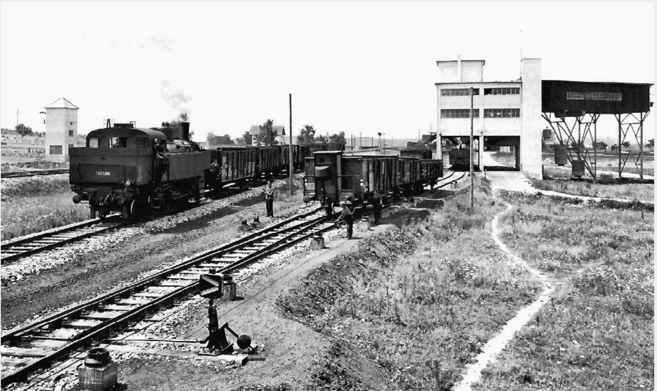
Oben: Fertig. Der reguläre Betrieb hat begonnen. Die Kohlen kommen, nachdem im Bergbau die taube Überlagerung abgebaut ist und das Flöz frei liegt, mittels der Abbau- und Fördergeräte, und den Zügen der 600 mm Feldbahn über den Kettenaufzug zum Brecher. Von dort mit den Wagen der Seilbahn in die Sieberei, werden in vier Klassen getrennt und verladen. Nach der Abwaage werden die Waggons zu Zügen zusammengestellt und können nach Wien gelangen.
