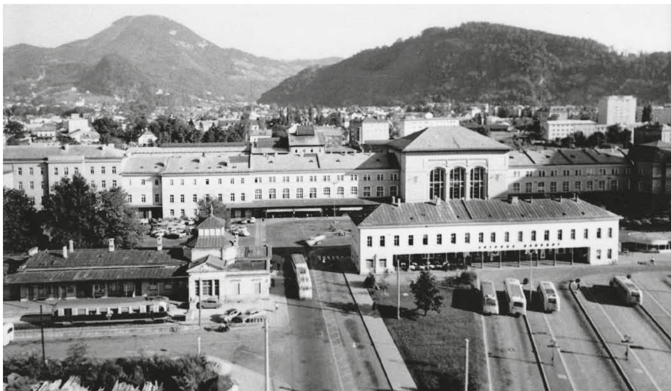
Auch wenn diese Aufnahme qualitativ den hohen Ansprüchen nicht genügen mag, so stellt sie zumindest vom Motiv her ein wertvolles Dokument dar. Es zeigt die drei Bahnhofsgebäude auf dem heute als Südtirolerplatz benannten Bahnhofsvorplatz. Links der bereits auf dem oberen Foto abgebildete Lokalbahn station, der erst 1908/09 errichtet wurde. Rechts daneben befindet sich das ursprüngliche Aufnahmegebäude, in dem bis zur Betriebseinstellung die Verwaltung der SKGLB untergebracht war. Anschließend wurde es für den Busbahnhof genutzt und schlussendlich 1978 abgetragen. Den Hintergrund dominiert der Hauptbahnhof Salzburg der ÖBB. (Foto: Sammlung Gunter Mackinger)
