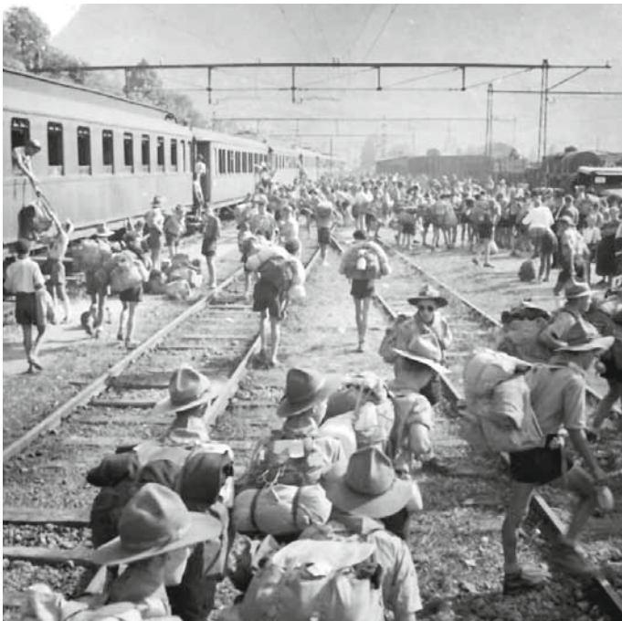
Aufgrund der großzügigeren Platzverhältnisse als am Personenbahnhof war der Bad Ischler Frachtenbahnhof besser für den Umstieg zwischen den Normalspurzügen und der Ischlerbahn geeignet. Am Rand der Schar von Kindern und Jugendlichen ist ein GMC-LKW der amerikanischen Besatzungsmacht am rechten Bildrand zu erkennen.
