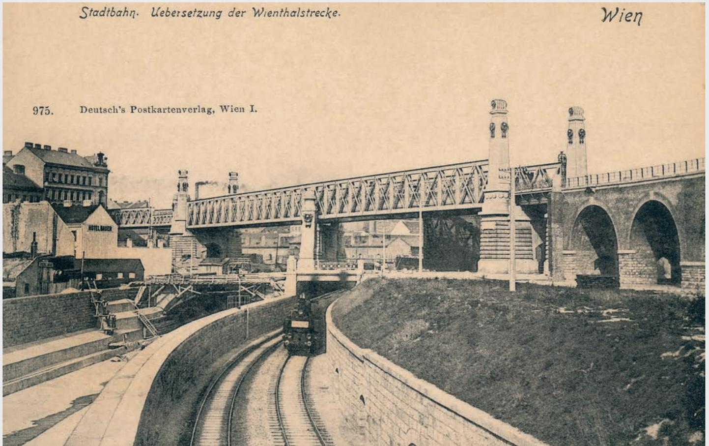
Den gestalterischen Höhepunkt der Brückenkonstruktion stellt das 112 Meter lange Mittelstück mit vier Pylonen als optische Lagerpunkte dar. Sie erheben sich knapp 14 Meter über die Lagerhöhe der Brücke. Die schräg angeordnete niedrige Mittelstütze trennt Wienfluss und Wientallinie. (Sammlung Josef Hlavač)
