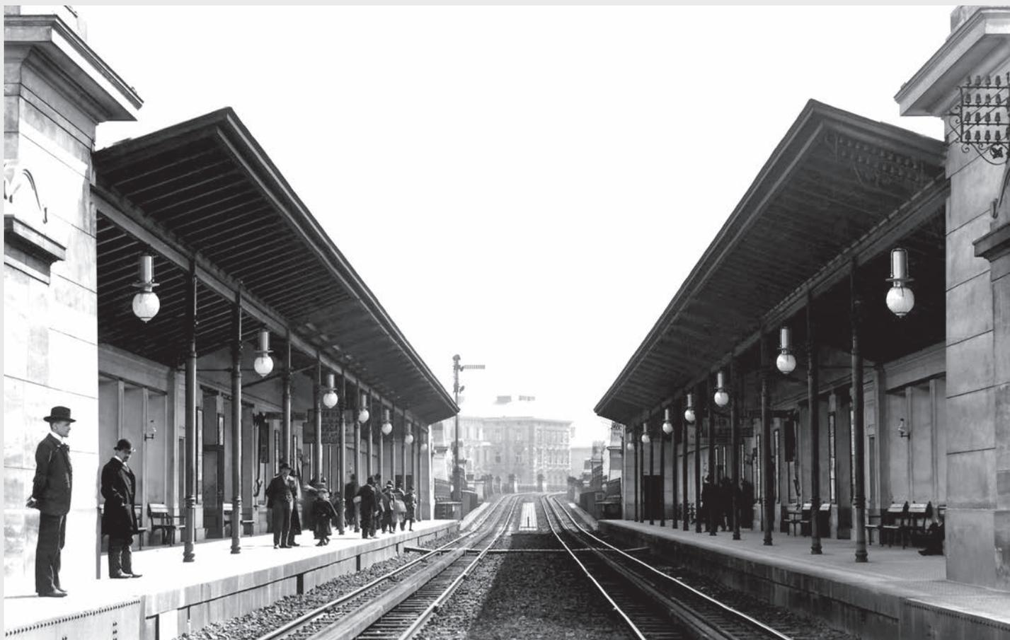
Fast schon wie Lampions dekorieren die Hängeleuchten die Bahnsteigvordächer der Währinger Straße. Dieses Bild entstand, als zwischen Michelbeuern und Heiligenstadt ein Probetrieb mit elektrischen Triebwagen absolviert wurde – zu sehen ist das Ausfahrtsignal Richtung Michelbeuern. (Sammlung Josef Hlavač)
