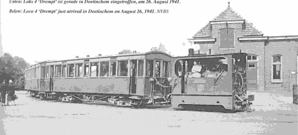
*Im Zweiten Weltkrieg kamen die Dampftrams wieder in Dienst. Da zu dieser Zeit schon mehrere Tramloks verschrottet waren, wurden teilweise Werkloks eingesetzt. Da diese keine durchgehenden Bremsen besaßen, wurde die Geschwindigkeit niedrig gehalten.*
