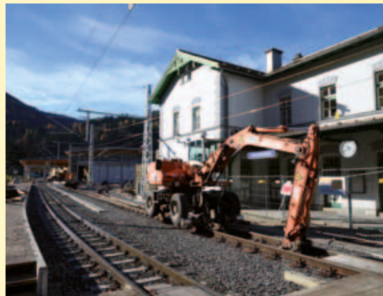
Zweiwege-Bagger vor dem historischen Aufnahmegebäude. Foto: Wolfgang Krippel, 08.11.2012
