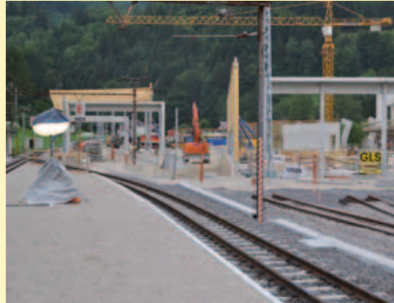
Die ersten Leimbinder sind bereits eingebaut. Foto: Wolfgang Krippel, 28.06.2012
